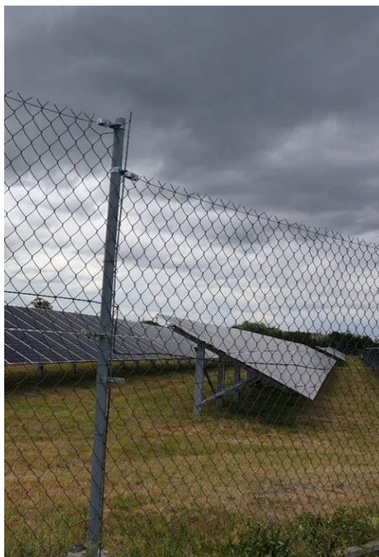
Fotografia 3 Sposób montażu paneli fotowoltaicznych na stelażach wbijanych bezpośrednio do gruntu
