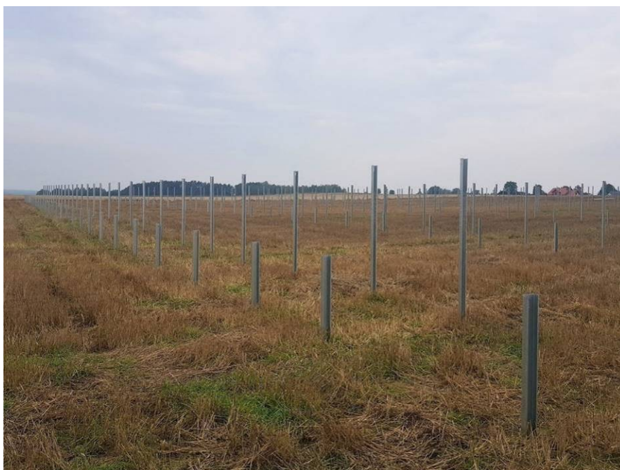
Fotografia 4 Profile metalowe: podstawowy element konstrukcji ( https://www.energy5.pl/ ).
