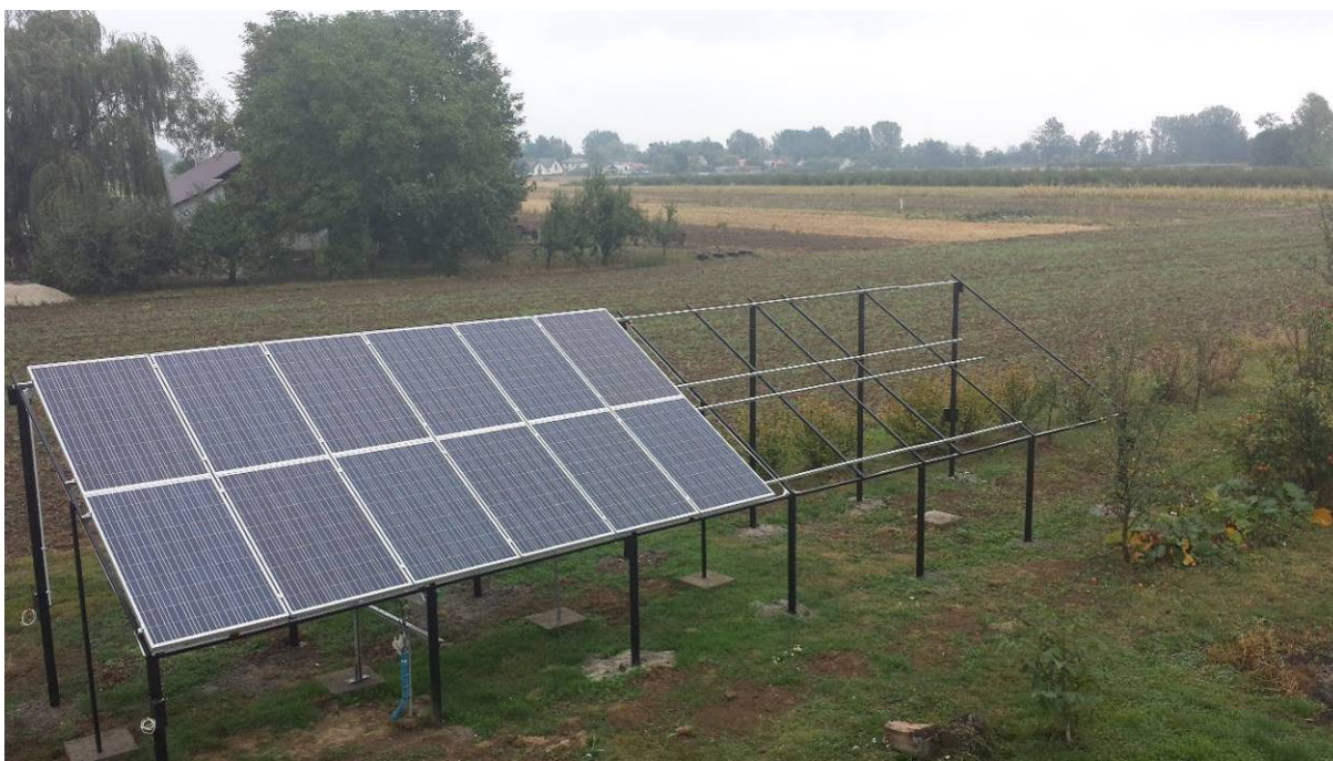
Fotografia 1 Konstrukcja stołu z panelami fotowoltaicznymi (www.elektroda.pl)
