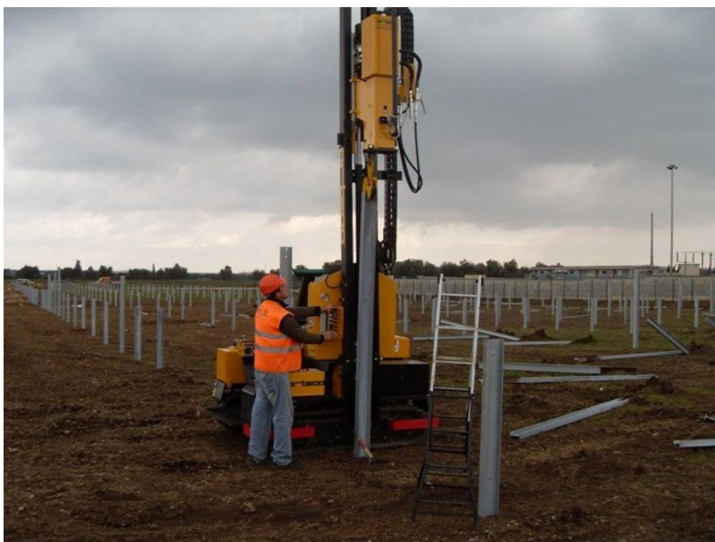
Fotografia 5 Montaż profili za pomocą kafara ( http://www.liftonpolska.pl/ ).
