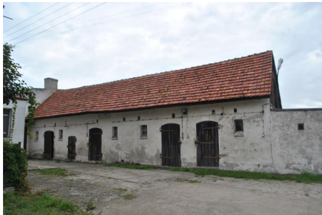
Budynek, widok od SW
