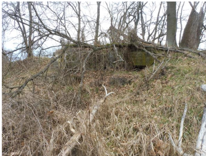
Schron, widok od SW
