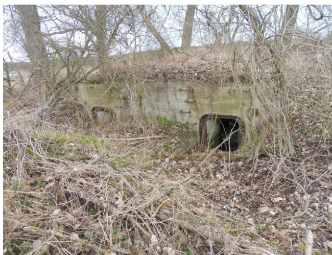
Schron, widok od SW
