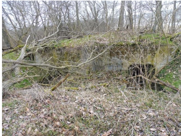
Schron, widok od SW
