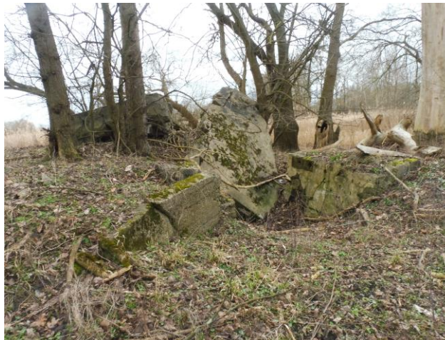
Schron, widok od SW
