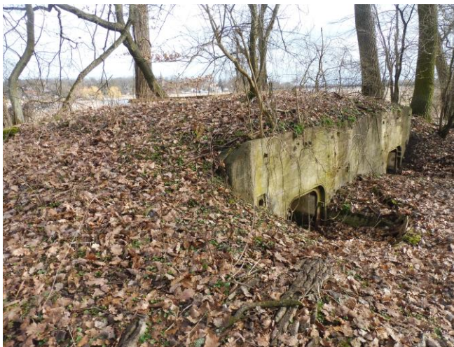
Schron, widok od SW
