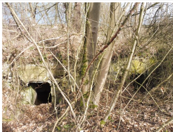
Schron, widok od SW
