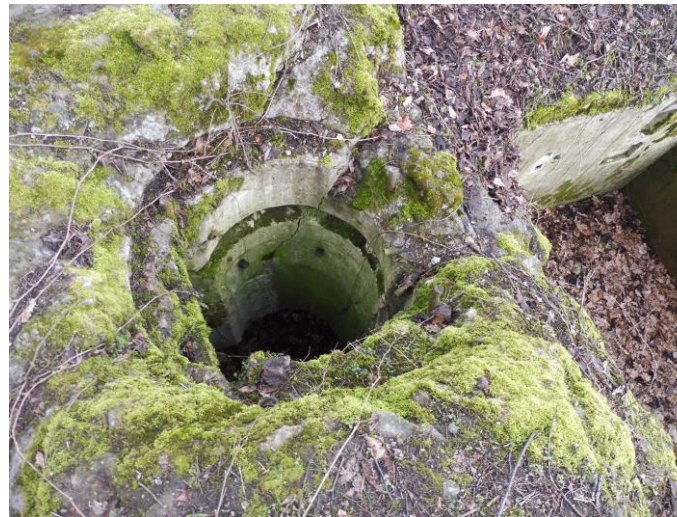
Schron, widok od SW
