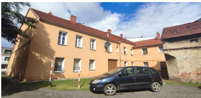
Budynek, widok od SE
