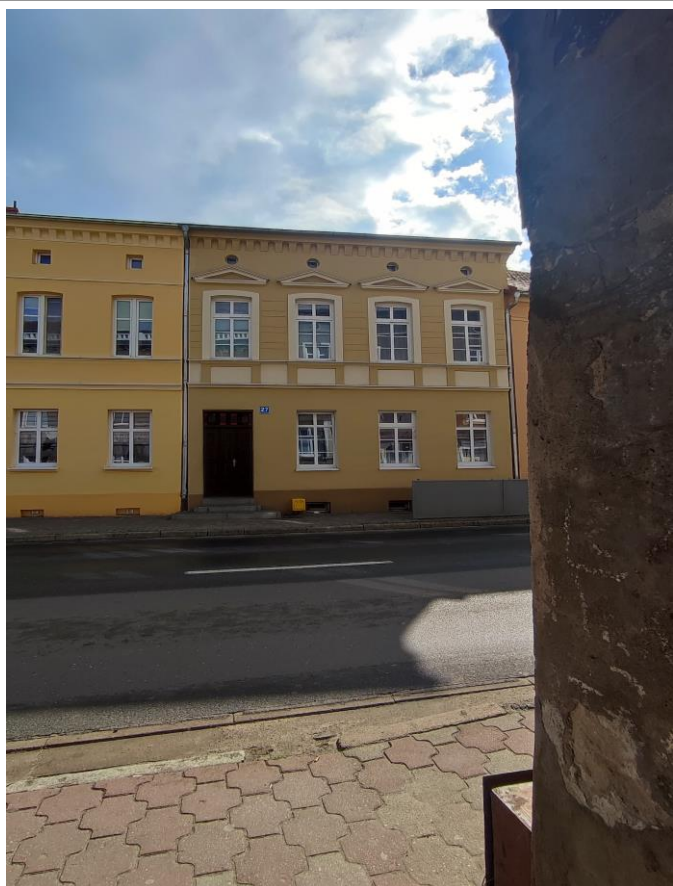
Budynek, widok od W
